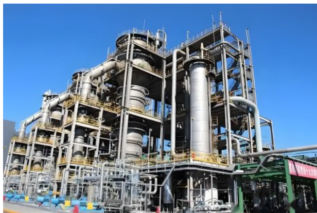
图6 首钢朗泽4.5万吨级产能的钢铁工业尾气生物发酵乙醇生产项目
